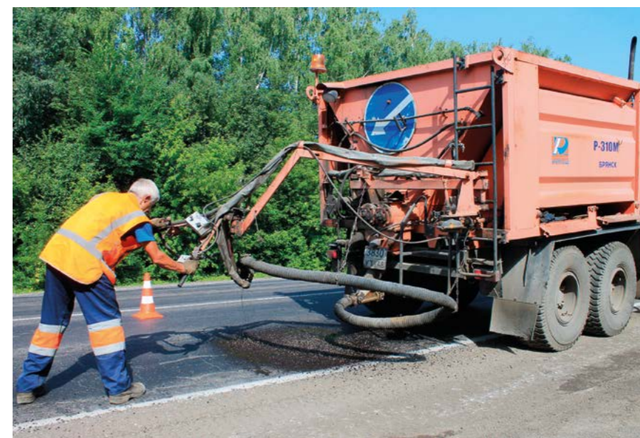
Струйно-инъекционный метод устранения дефектов дорожного покрытия
