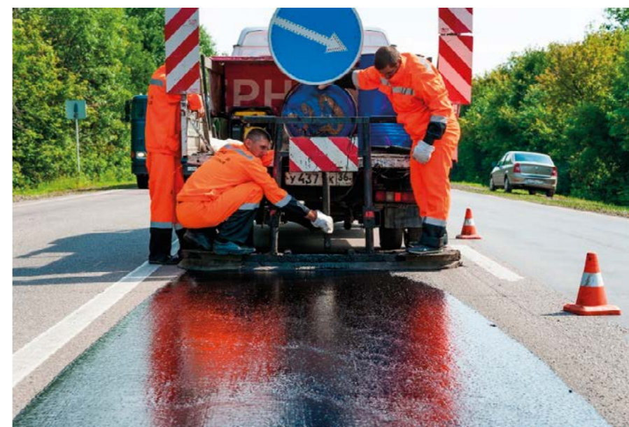
Нанесение защитного слоя
