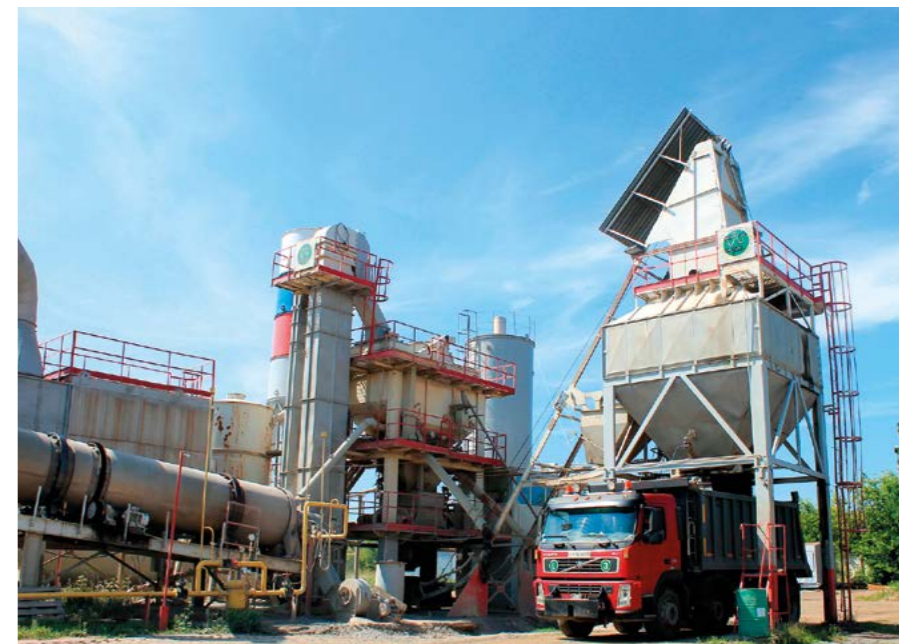
Асфальтобетонный завод итальянской марки BERNARDI (г. Задонск)
